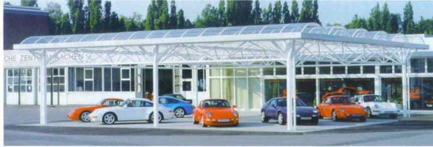
■ Hagelschäden sind ein Horror für jeden Automobilhändler. Acrylüberdachungen schützen davor. (Foto: Roda-germany.de)
