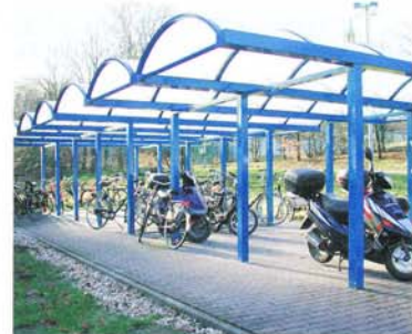
Die Überdachung von Fahrradabstellplätzen ist obligatorisch. Mit solchen leichten Systemen aus Metall und Acrylglas lassen sich auch für den Schulhof kostengünstige Lösungen realisieren.
