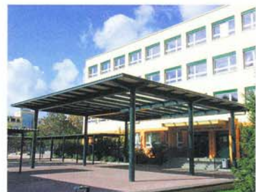
Der Eingangsbereich der Selma-Lagerlöf-Grundschule in Berlin erhielt eine ca. 90 Quadratmeter große Überdachung, die einen Aufenthalt auf dem Hof auch bei schlechtem Wetter ermöglicht.
