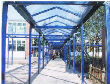
Gesamtschule Hamburg-Finkenwerder: Die Überdachung der Verbindungswege zwischen den einzelnen Gebäudekomplexen ist Wetterschutz und Aufenthaltsmöglichkeit zugleich.
