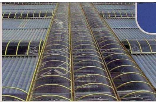
**Patentiertes Rinnensystem:** Bei diesen freitragenden Gewölbe- und Sattelkonstruktionen ist das stranggepresste Aluminiumprofil Entwässerungsrinne und Dachträger zugleich.
