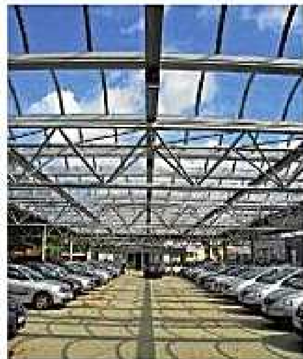
Schutz vor Hagelschlag: Weitreichende Überdachungen verhindern, dass sich Hagelunwetter im Extremfall zu einem finanziellen Desaster für den Kfz-Unternehmer entwickeln.
